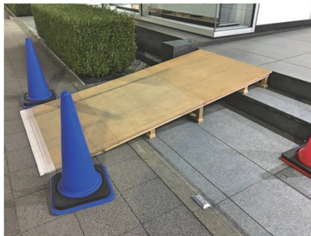
簡易スロープの設置
