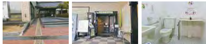
入口スロープ
