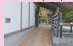
新館スロープ(出入口)
