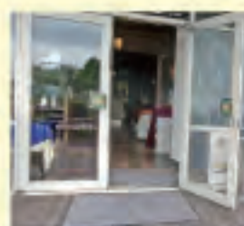
レストランのテラス席への扉は、両開き。約1.5cmの段差あり。
