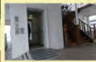
エレベーターで3階まで上がれます。エレベーター前のスロープが少し勾配がきつくなっています。
