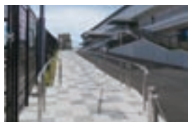
傾斜のある歩道
