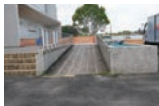
入口のスロープ
