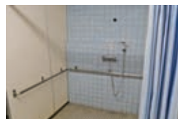
車いす用シャワールーム
